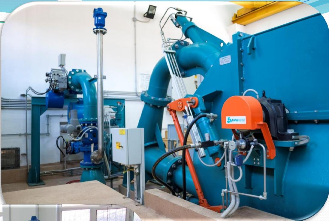
Uljno tlačni agregat za upravljanje deflektorom, iglama i leptirastim zatvaračima:
