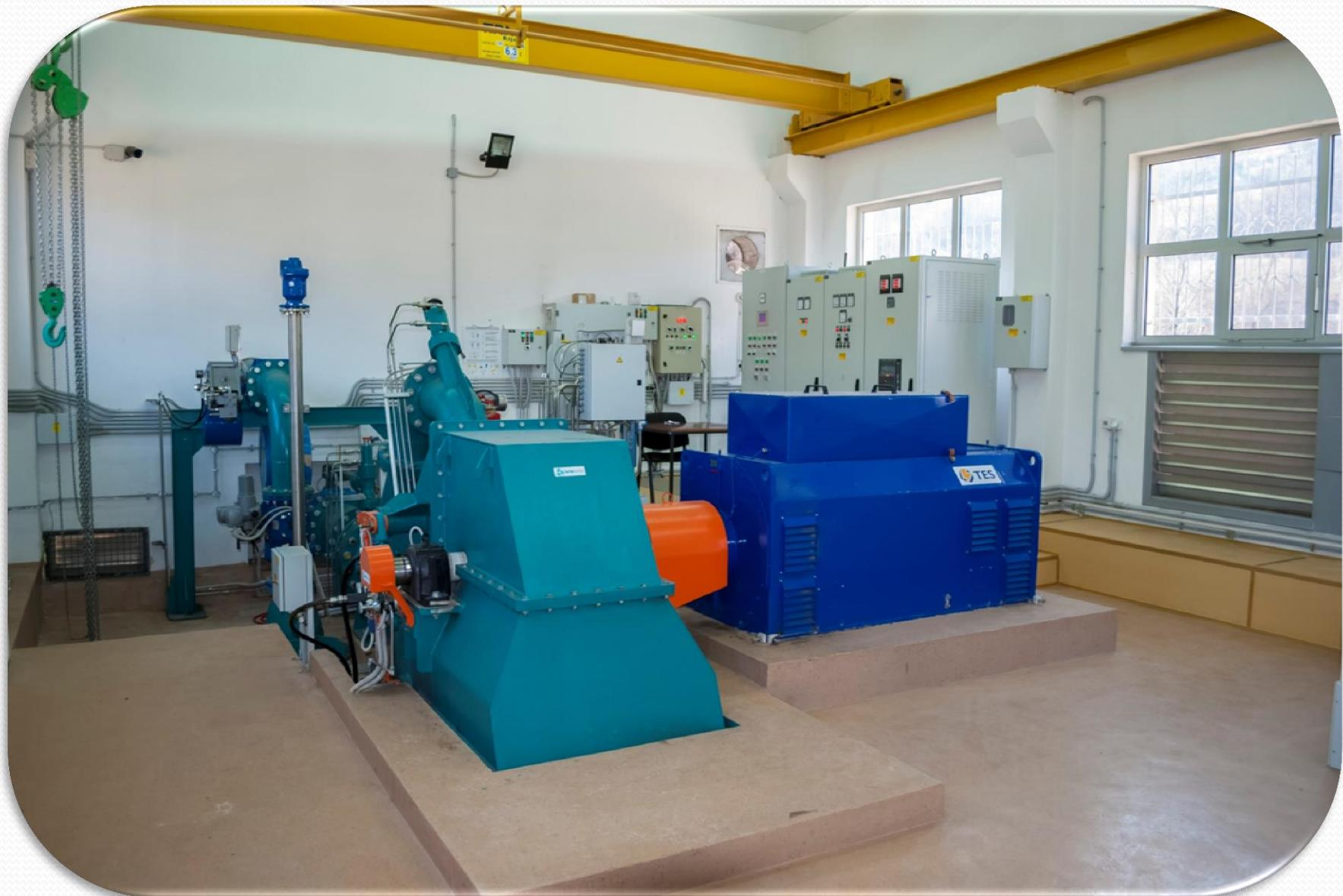
Hidroelektrana je projektovana i izgrađena tako da radi u automatskom režimu i bez posade. Sistem nadzora i upravljanje se vrši iz telemetriskog centra JP "Vodovod i kanalizacija" d.o.o. Zenica.
